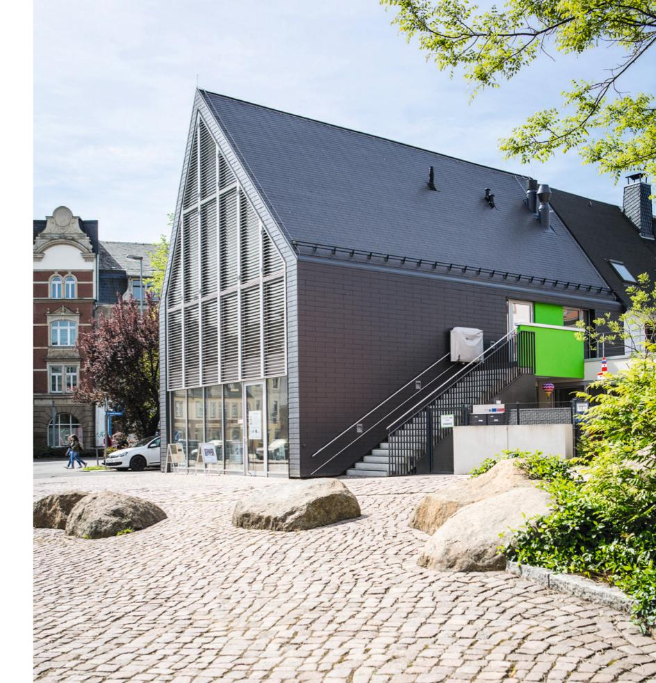
Le pignon asymétrique est structuré par la façade à montants et traverses. Un système de protection contre le soleil composé de lamelles horizontales intégrées à la structure interne assure des températures agréables à l'intérieur du bâtiment.
