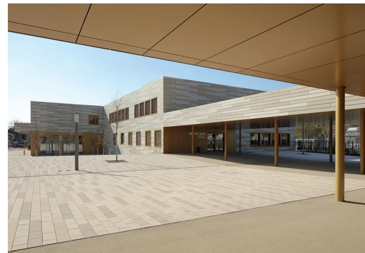
Die langgestreckte Form des Gebäudes war für die Fassadengestaltung ausschlaggebend. Durch den Einsatz von schmalen und langen, lasierten Faserzement-Paneelen mit den Abmessungen von drei Metern auf 18,5 Zentimetern und drei Farbtönen des beigen Farbspektrums wurde ein Musterverlegeplan erstellt um auch das Fugenbild bei der Realisierung von Anfang an im Griff zu haben. Das Ergebnis ist ein äußerst präzises Fassadenbild das bis in die kleinste Ecke durchdracht wurde.
